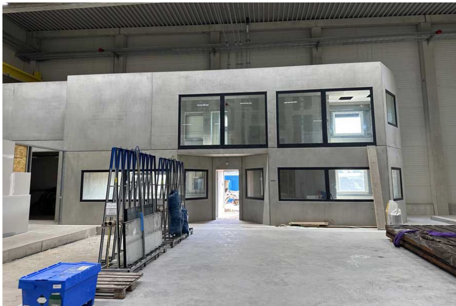
Bild: Das neue Werk von Menzel Elektromotoren schreitet planmäßig zügig auf seine Fertigstellung zu (im Bild: Prüffeldkabine mit Kundenbereich)
