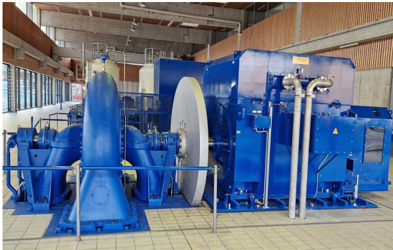
Bild: Alles aus einer Hand: Menzel fertigte einen Schleifringläufermotor mit Bürstenabhebevorrichtung, Grundrahmen, Kupplung und Flüssigkeitsanlasser und übernahm die Demontage des Altmotors und die Aufstellung und Inbetriebnahme des neuen Pumpenmotors
