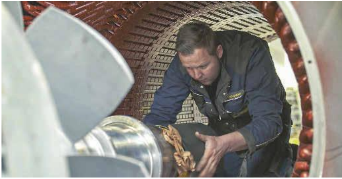
Riesige Dimensionen – ein Mitarbeiter geht in den Motor hinein, um das Einfahren des Läufers in den Ständer vorzubereiten
